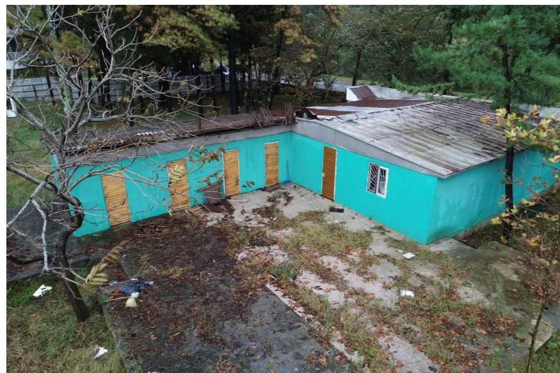
სურ 4. საპროექტო ტერიტორიაზე არსებული შენობა - ნაგებობა
