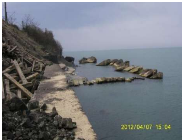
სურათი1-22. დაზიანებული ტალღამრეკლი კედელი და სამშენებლო ნარჩენები (ციხისძირი)
