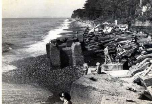
სურათი1-20. რიაჟები და რკინა-ბეტონის მასივები ზუკნარის სანაპიროზე
