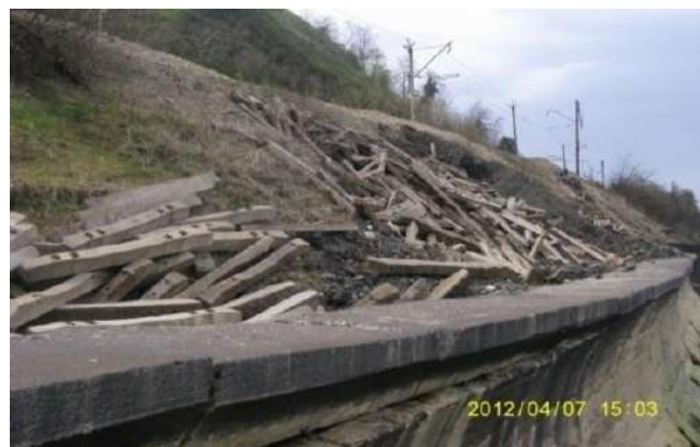
სურათი1-22. დაზიანებული ტალღამრეკლი კედელი და სამშენებლო ნარჩენები (ციხისძირი)
