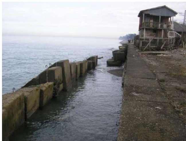
სურათი 1-17. ტალღის მიერ კედლის უკან გამორეცხილი ძაბრისებური ფორმა (ჩაქვი)
