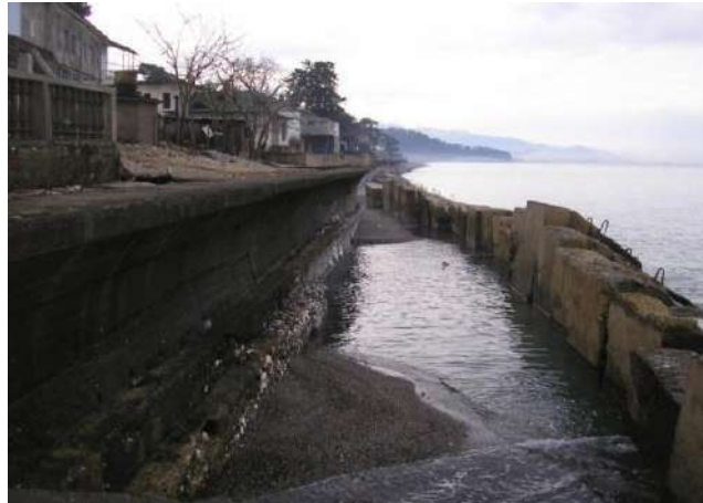
სურათი1-16. ტალღამრეკლი კედელი და მრავალტონიანი რკინა-ბეტონის მასივები
