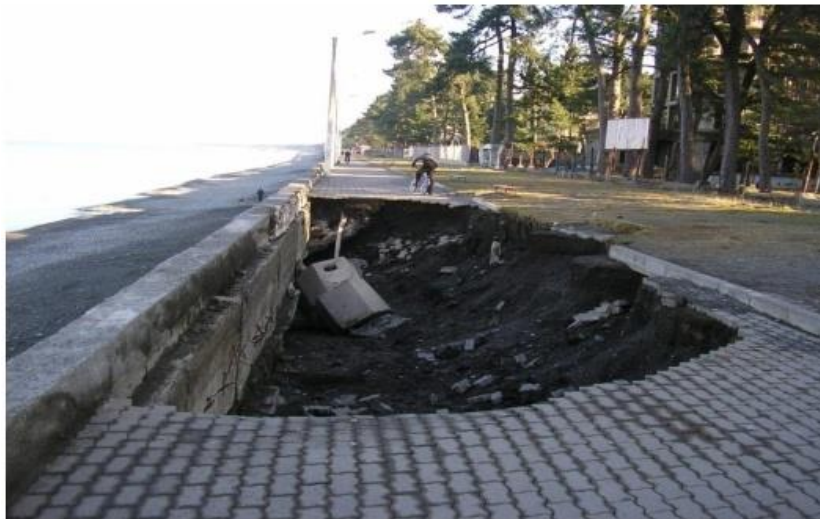
სურათი 4. ქობულეთის სანაპიროშტორმის შემდეგ ადდაზიანებული ბუფარი. 2015 წ
